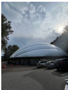
1. Air sprung structure
